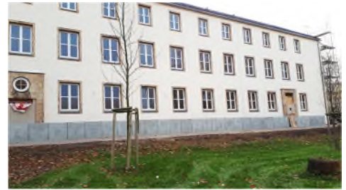
Das Gerüst ist seit November 2021 weg
